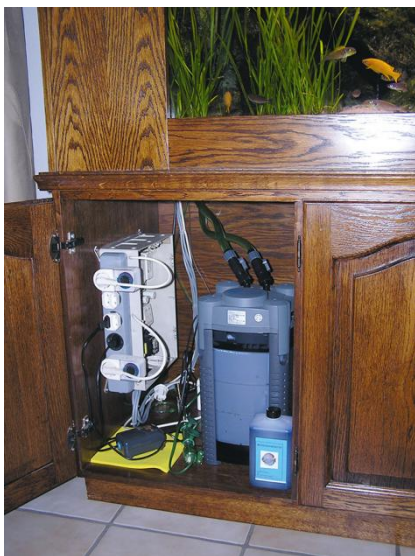
De pomp reinigen behoort bij het onderhoud
